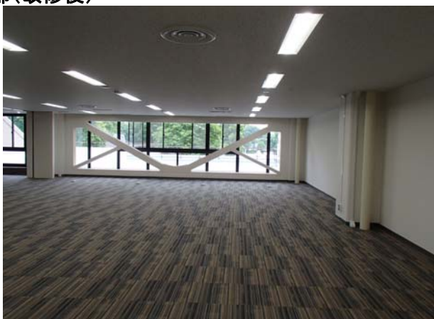
(図書館) 耐震ブレース設置
