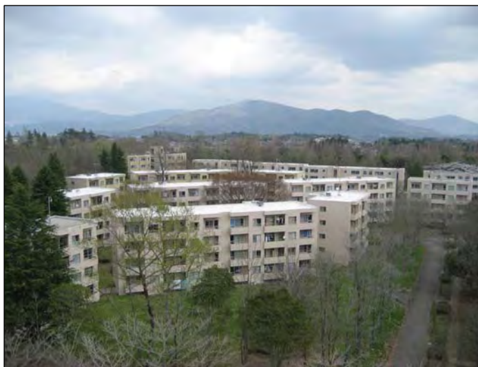
完成(一の矢学生宿舎全景)
