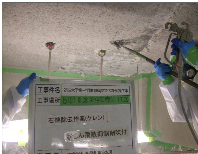
自然系学系B棟 除去作業中
