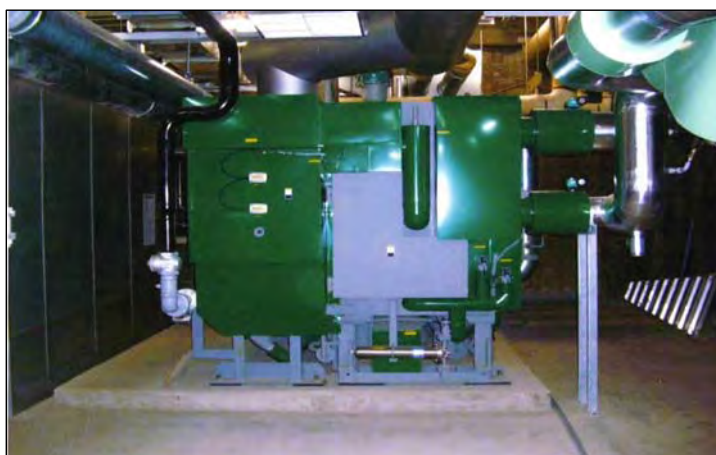
既設空調機の更新に機械室の機器を整理し、冷凍機を増設配置
