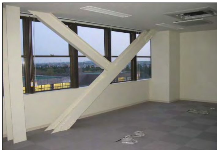
6階耐震補強完成
