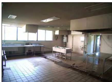
着工前(旧厨房)
