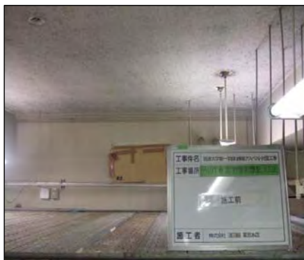
自然系学系B棟 着工前
