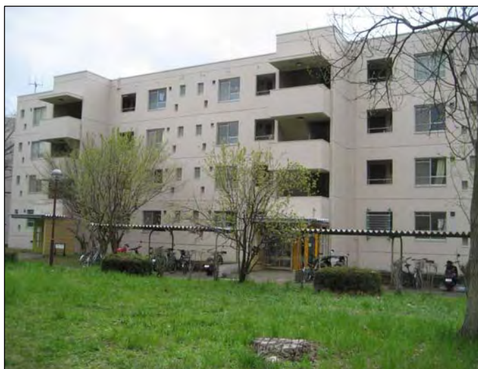
完成(一の矢学生宿舎14号棟北面)
