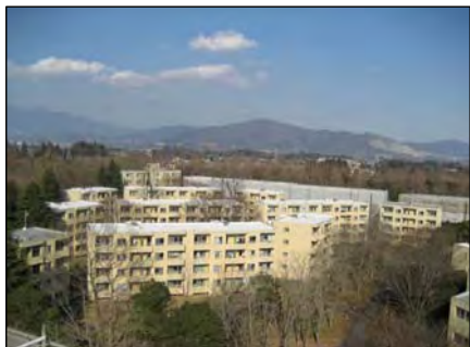
着工前(一の矢学生宿舎全景)
