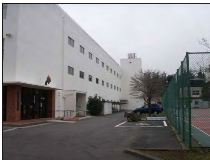
完成(附属高校北外壁面)
