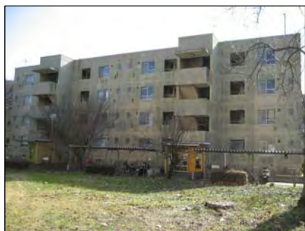
着工前(一の矢学生宿舎14号棟北面)
