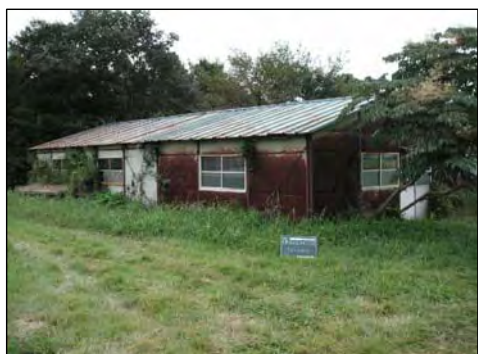
工作棟 着工前
