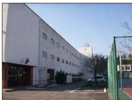
着工前(附属高校北外壁面)
