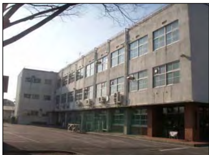
着工前(附属高校東外壁面)
