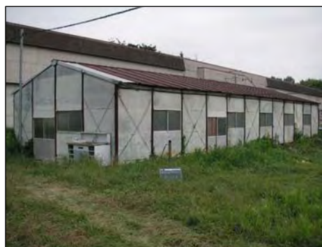
水路棟 着工前
