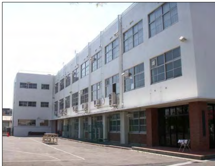
完成(附属高校東外壁面)
