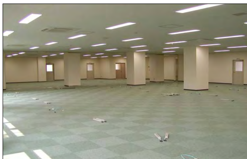
完成 2階共同実験室
