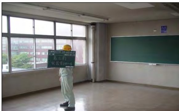
実習室(中)－4 改修前
