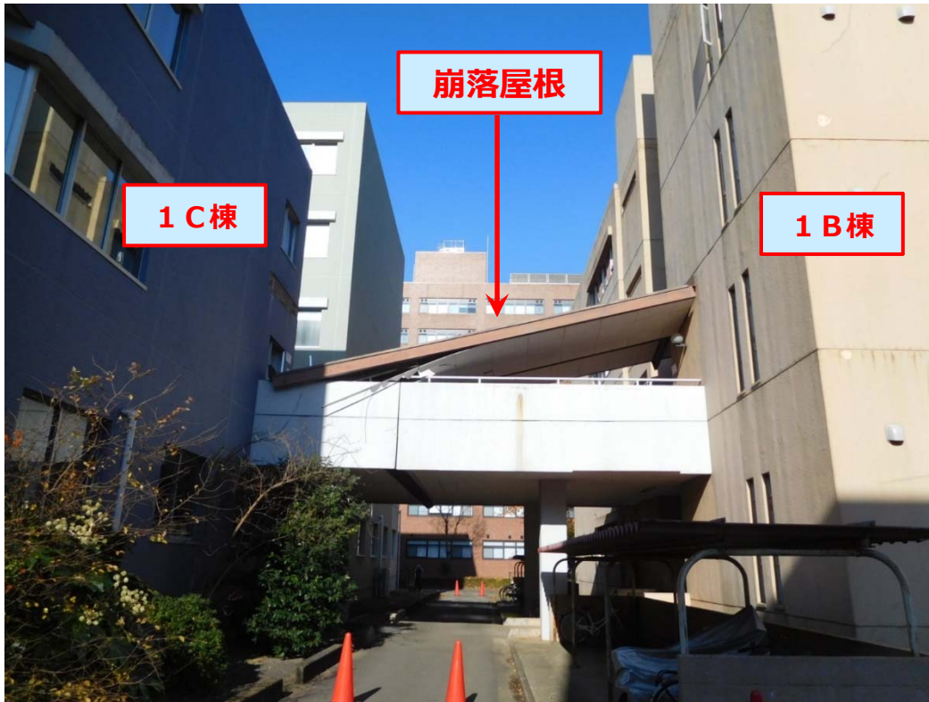
a. 屋根崩落状況全景
