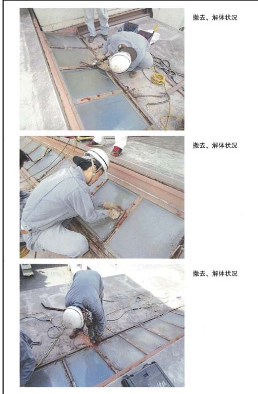
c. 撤去，解体状況
