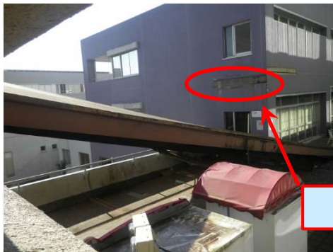
b. 1C 棟側崩落状況
