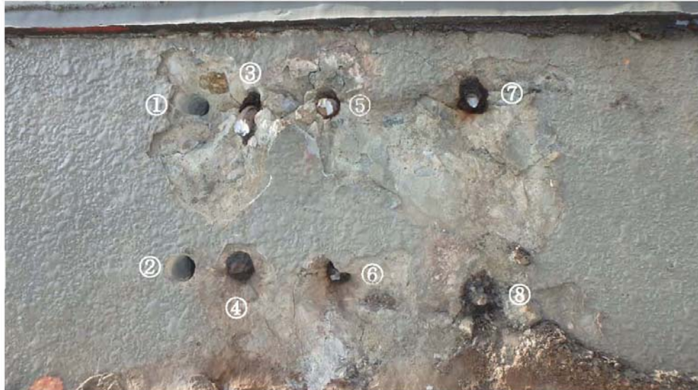
写真-10 取付部 C1 の状況
