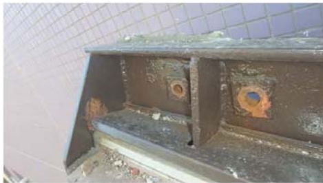
写真-4 露出部分の状況
