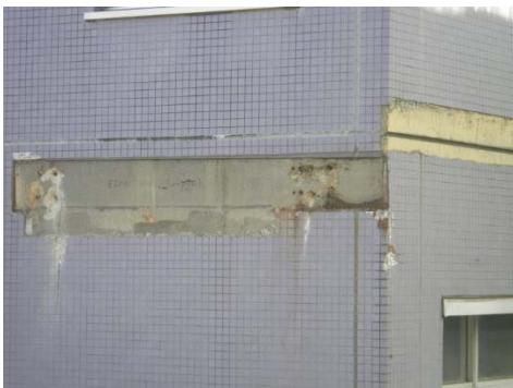
d. 1C 棟側崩落跡①（b 拡大）
