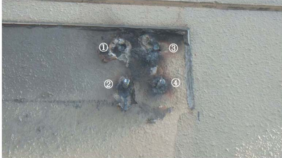
写真-9 取付部 B2 の状況
