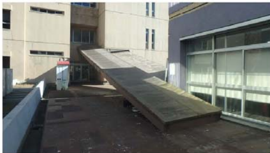
写真-2 崩落状況
