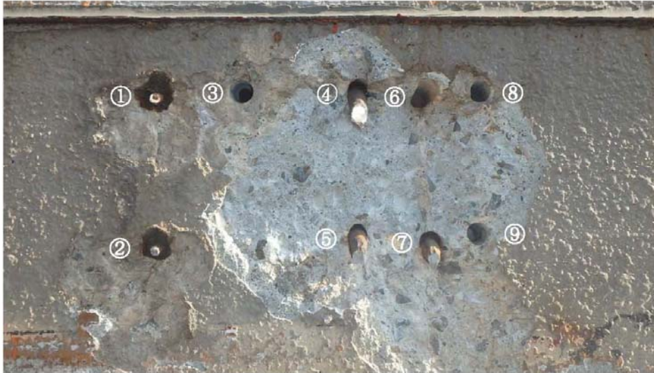
写真-8 取付部 B1 の状況
