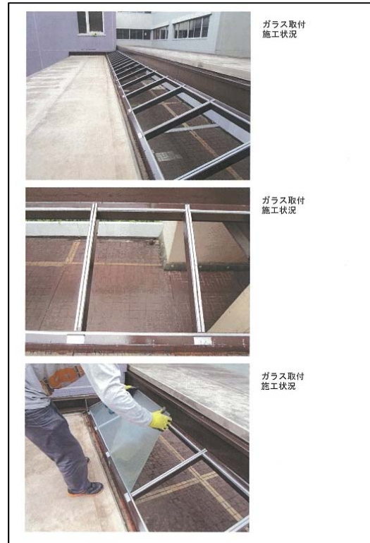
h. ガラス取付施工状況
