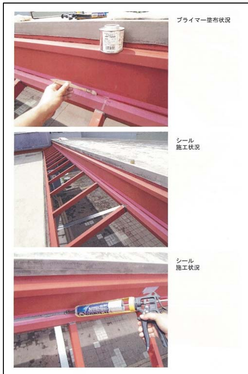
g. シール施工状況
