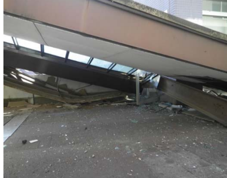
i. 屋根崩落状況（北側より）
