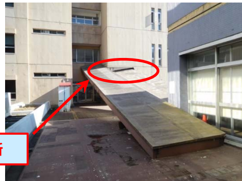
c. 1B 棟側崩落状況
