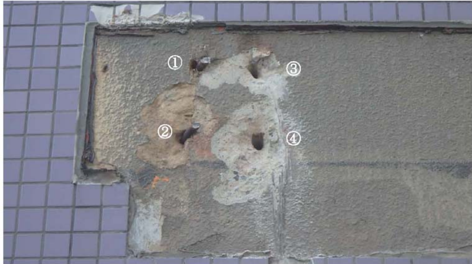
写真-11 取付部 C2 の状況
