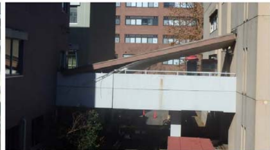
写真-3 崩落状況
