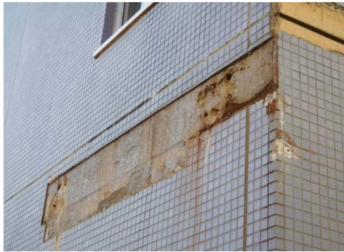
f. 1 C 棟側崩落跡②（d 拡大）
