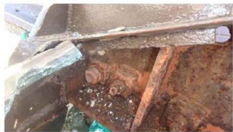
写真-5 躯体、鉄骨取付部（屋根裏鉄骨側）
