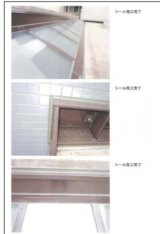
j. 施工完了
