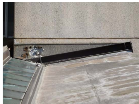
e. 1B 棟崩落跡（c 拡大）
