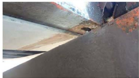
写真-7 ルーズホール部
