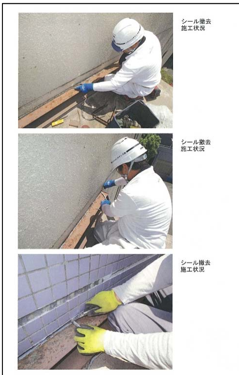
e. シール撤去施工状況
