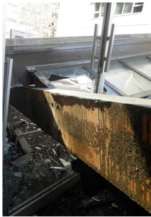
k. 1 C 棟出入口②
