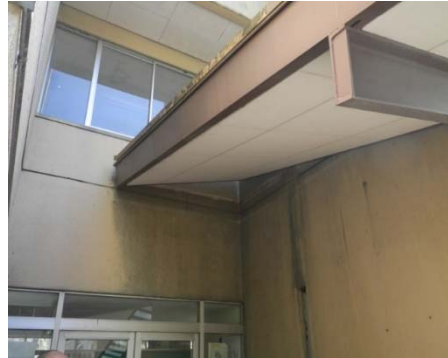
g. 1 B 棟側崩落屋根端部
