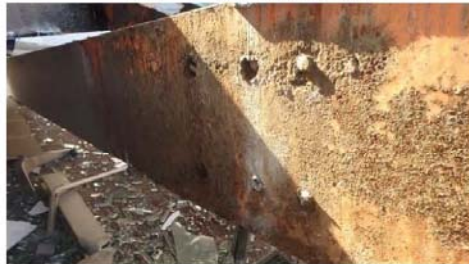
写真-6 鉄骨部材の状況
