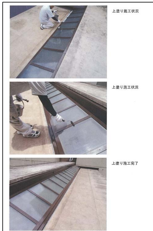
i. 塗装施工完了
