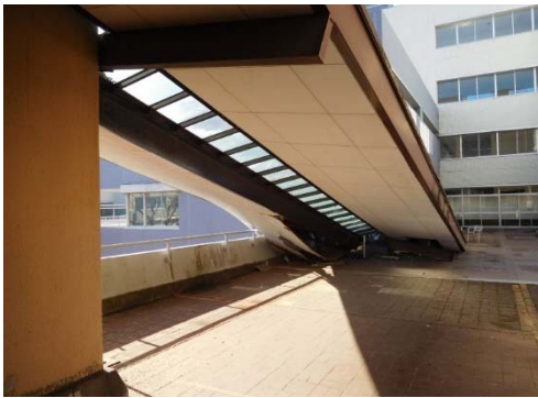
h. 1 B 棟出入口より 1 C 棟を見ル
