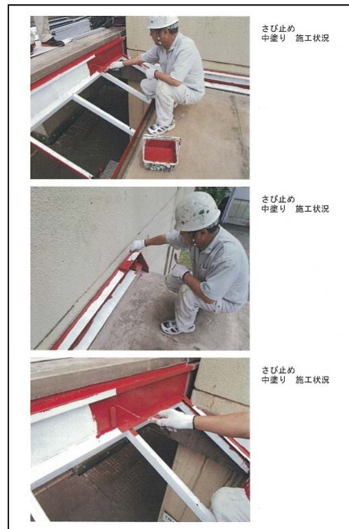
f. さび止め塗装施工状況
