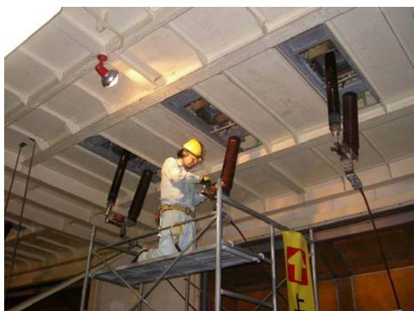
2・3号特高変圧器耐圧試験準備完了
