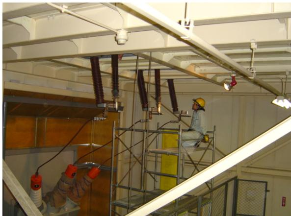
2号特高変圧器断路器超音波試験中
