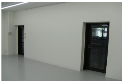
耐震壁(増打ち)
